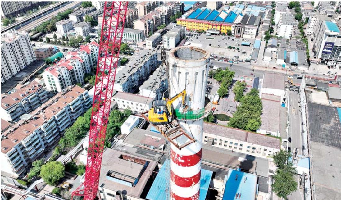
5月23日，明湖热电厂100米高的燃煤锅炉烟囱顶部开始拆除作业。
